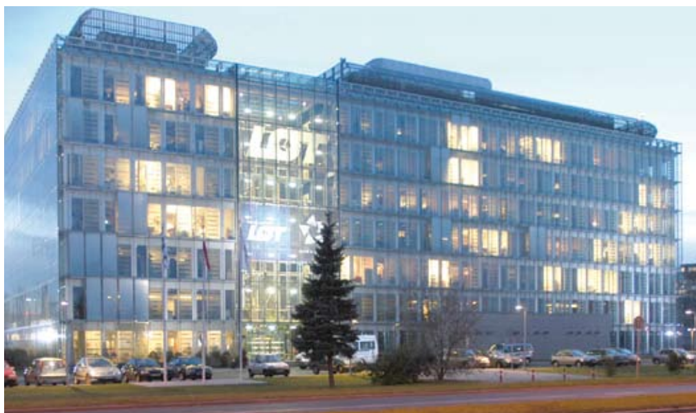
Biurowiec PLL LOT w Warszawie. Stropy aktywowane termicznie firmy REHAU zapewniają komfortową temperaturę na 18 000 m 2 powierzchni użytkowej.
