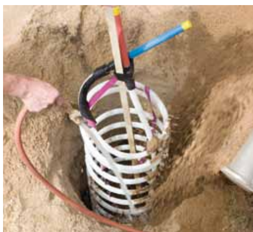
Montaż sondy RAUGEO Helix PE-Xa
