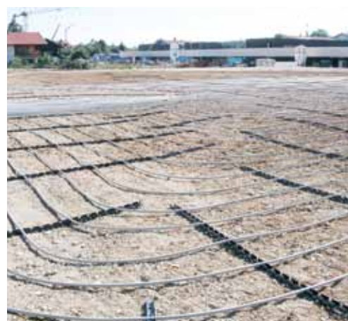
Układanie kolektorów geotermalnych RAUGEO
