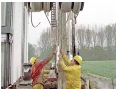
Montaż sondy geotermalnej RAUGEO
